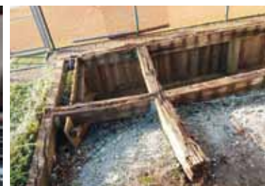
Der defekte Unterbau der Terrasse
